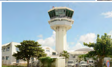
Tour de Contrôle Aéroport de Fort de France (Martinique) / Fort de France Airport Control Tower (Martinique)
